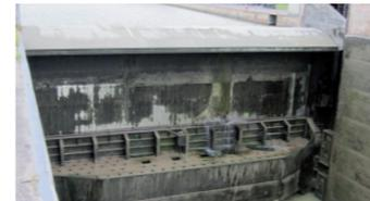
**Unterhaupt** Torkonstruktion am stromabwärtigen Ende der Schleuse
